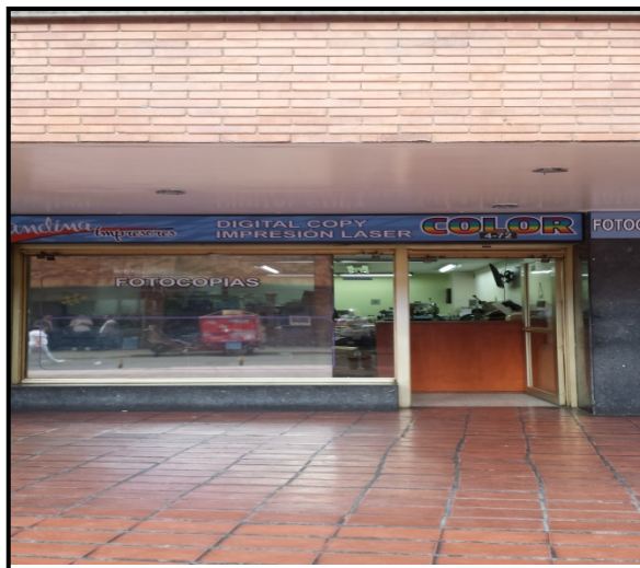
Foto No. 2. Fachada del predio de la Calle 17 No.4-72
